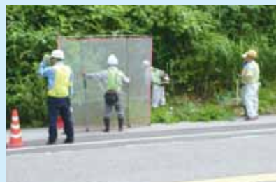
▲ 新温泉町内の国道9号線沿いの草刈り作業の様子
